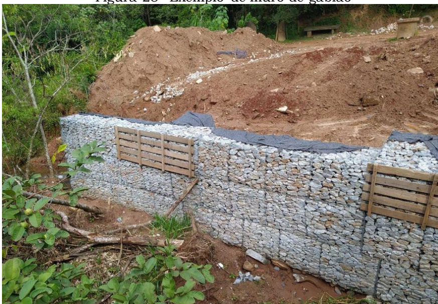
Figura 28– Exemplo de muro de gabião
