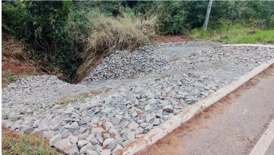
Figura 8- Exemplo de utilização de enrocamento para contenção
