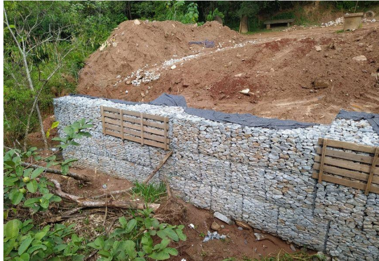
Figura 9– Exemplo de muro de gabião
