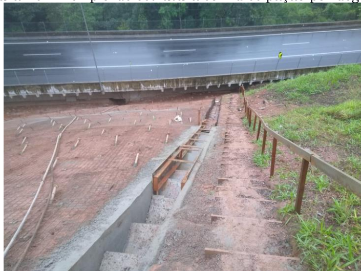
Figura 10– Exemplo de estrutura com dissipação por degraus
