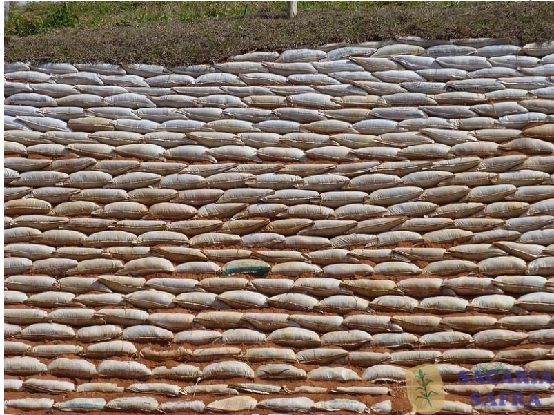
Figura 7- Exemplo de utilização de Rip Rap para contenção
